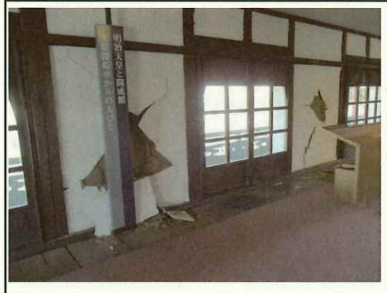
開成館 壁修繕
