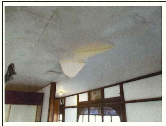
開成館3階 天井修繕
