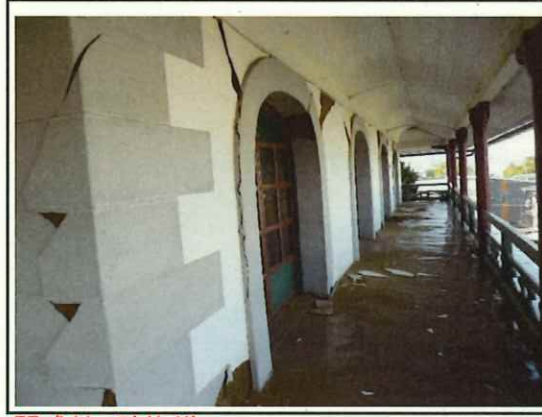
開成館 壁修繕
