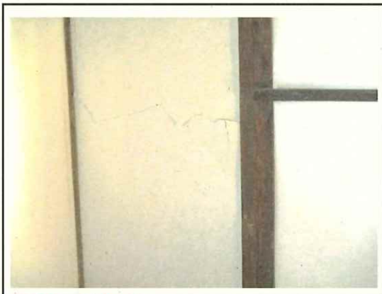
開成館 壁修繕
