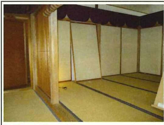
開成館 床等木工事
