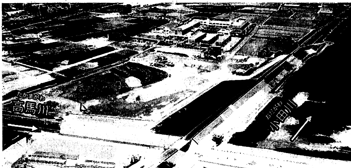
P.6の復旧状況
