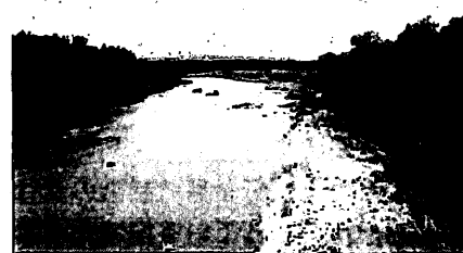
阿武隈川の小和滝付近の河道掘削
