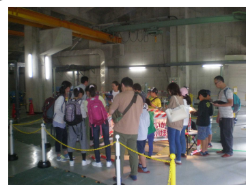
湖南浄化センター内見学の様子
