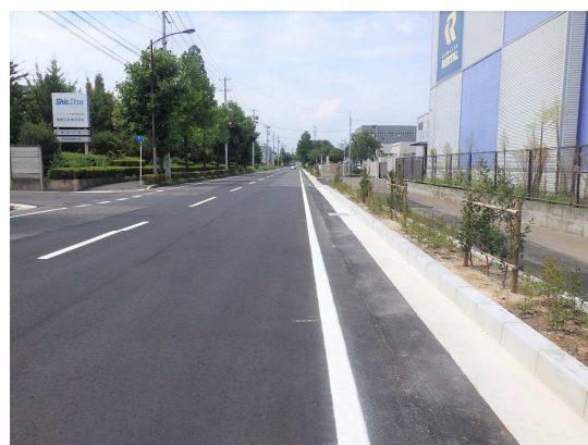
歩車道境界ブロック・植栽復旧完了 (東側から西側を望む)
