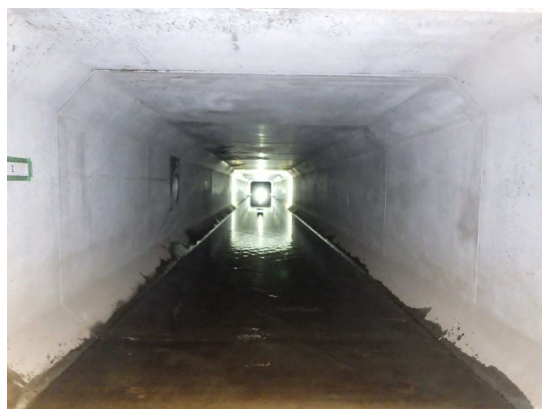
133号 ボックスカルバート内部状況
