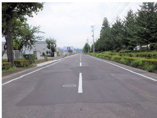
歩車道境界ブロック・植栽復旧完了 (西側から東側を望む)
