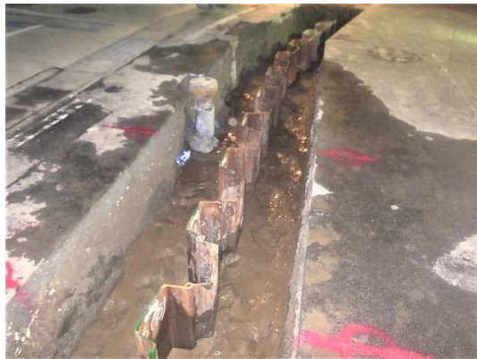
鋼矢板設置完了
