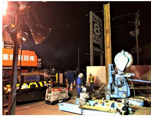
鋼矢板圧入状況
