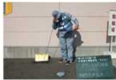
【音聴調査】メーター等に金属棒の先端を接触させ漏水音を聴き取る方法
