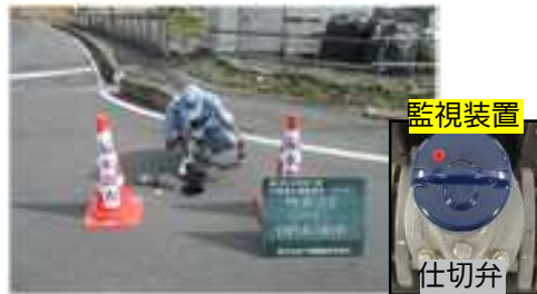
【監視型漏水調査】数日間、水道管の仕切弁等の付属設備に監視装置を設置し、漏水を判定する方法
