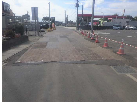
覆工板設置完了
