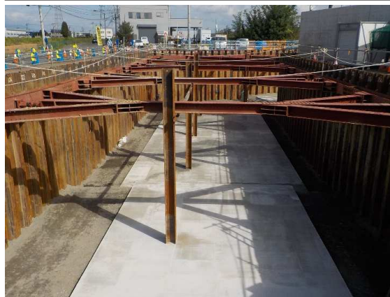
ポンプ施設部均しコンクリート完了
