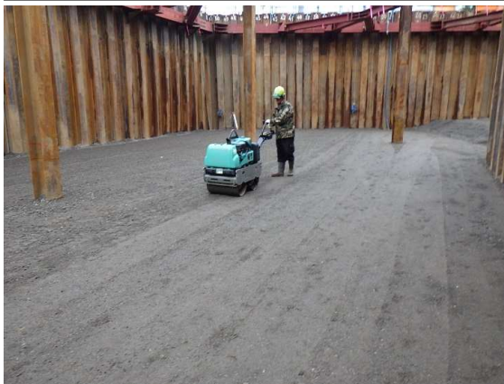
ポンプ施設部基礎砕石施工状況
