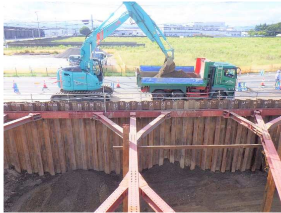
ポンプ施設部掘削状況
