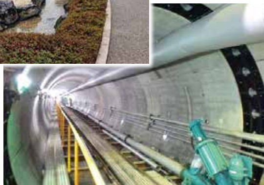
雨水貯留施設の整備「図景貯留管」
