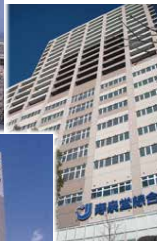
駅前一丁目地区(再開発ビル)
