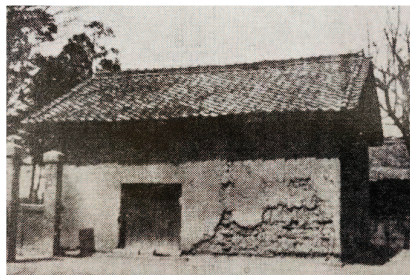
盛隆舎が建てられたころの蔵場地区の様子 （金透創立150周年記念誌 金透坂より）
