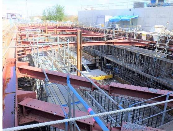
ポンプ施設部鉄筋組立状況
