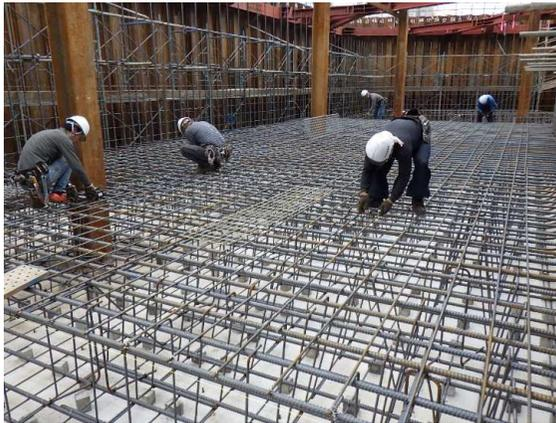
ポンプ施設部鉄筋組立状況
