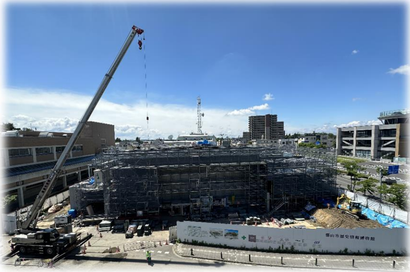
工事状況（R6.6末撮影） 進捗率：約80%
