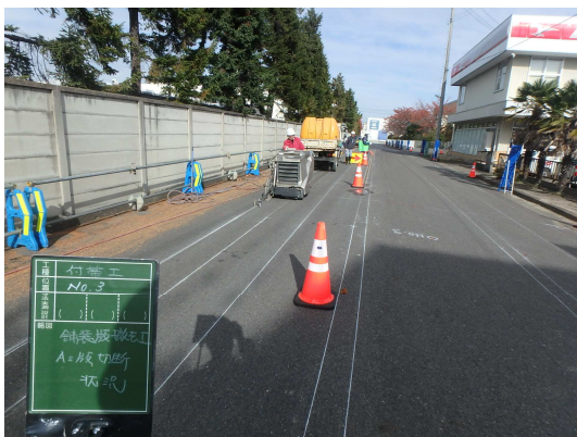
アスファルト切断状況
