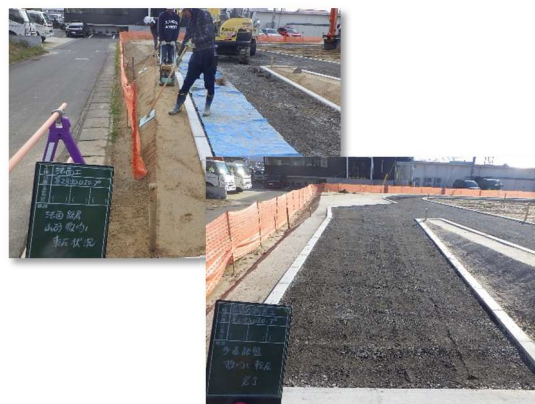
法面工、園路舗装工(歩道路盤)
