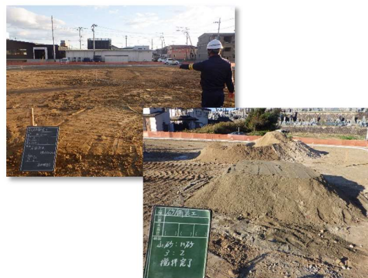
砂舗装工(掘削完了、山砂・川砂搬入攪拌)
