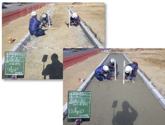
園路舗装工(フィルター層)
