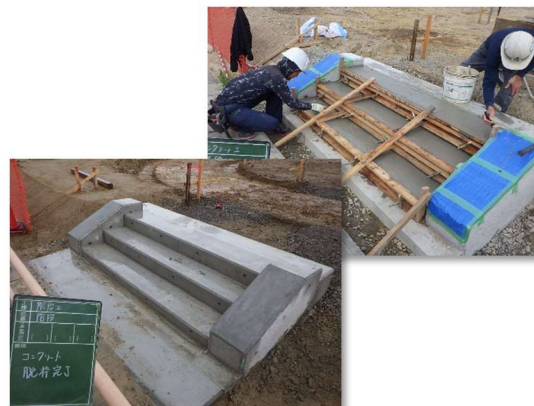
階段工(コンクリート打設)(西側を望む)
