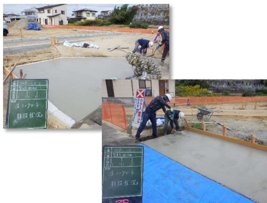
1号・2号出入口工(コンクリート打設)
