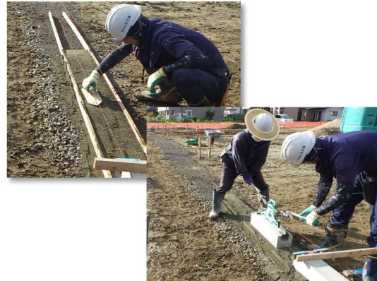
地先ブロック設置(敷外～ブロック据付)
