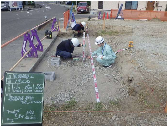
出入口工(掘削深確認)(北側を望む)
