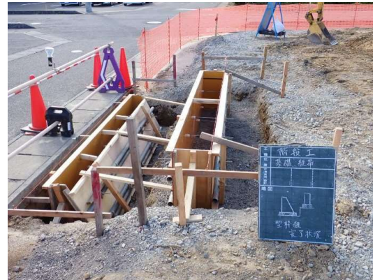
階段工(型枠設置)(西側を望む)
