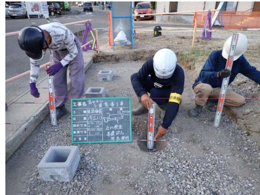
出入口工(掘削深確認)(北側を望む)
