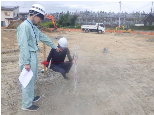
敷地造成工(掘削深確認)(北側を望む)
