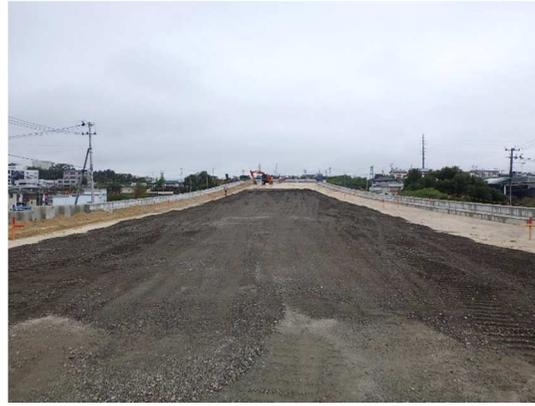
下層路盤工施工状況
