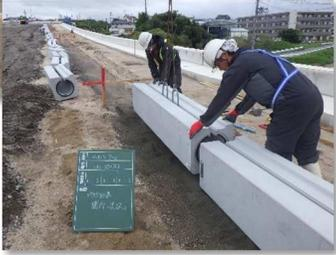
排水構造物(円形側溝)設置状況
