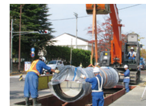
老朽化した水道施設の交換作業
