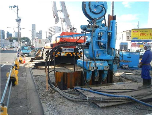
仮設土留め(鋼矢板圧入)施工状況(北西側を望む)
