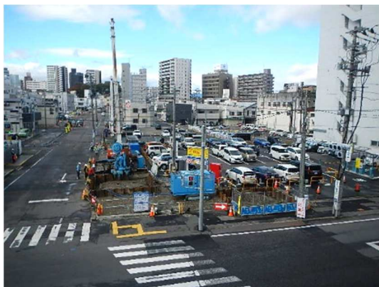
仮設土留め(鋼矢板圧入)施工状況(全景)
