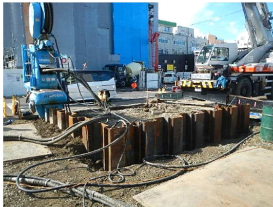
仮設土留め(鋼矢板圧入)施工状況(南西側を望む)
