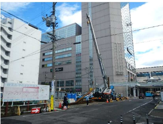
仮設土留め(鋼矢板圧入)施工状況(北東側を望む)
