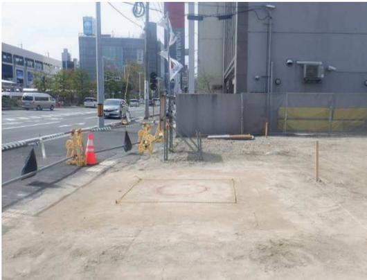
フーチング基礎工施工(埋戻し)完了(S-KP1)
