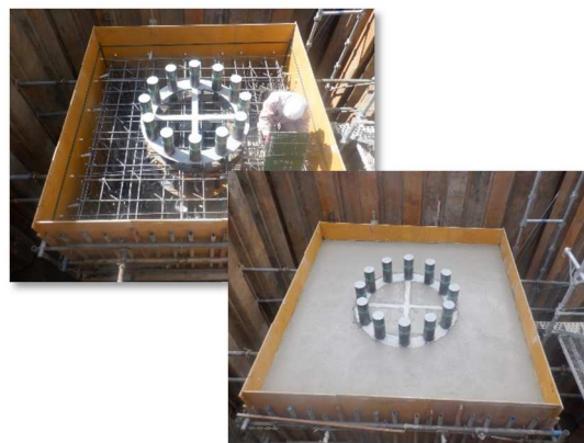
フーチング基礎工施工状況(S-P2)
