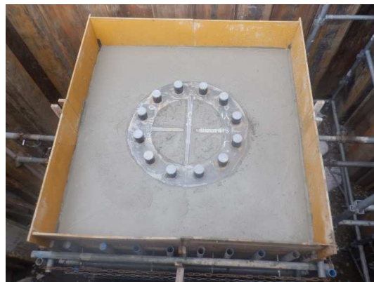
フーチング基礎工(コンクリート打設完了)施工状況(S-KP1)
