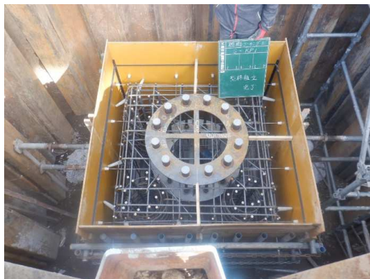
フーチング基礎工(型枠・配筋完了)施工状況(S-KP1)
