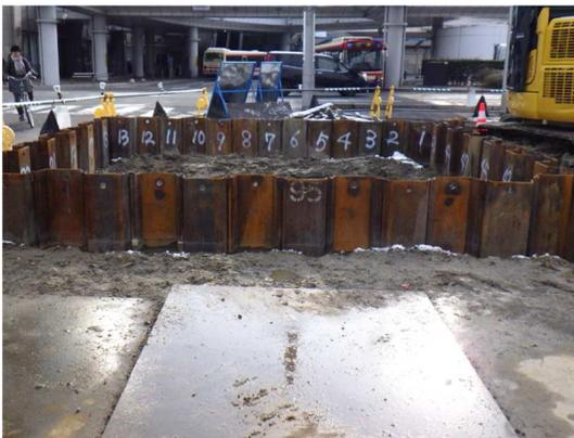
仮設土留め(鋼矢板)設置完了状況
