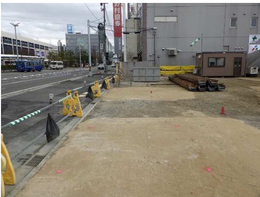
小口径回転杭工施工完了(南側を望む)
