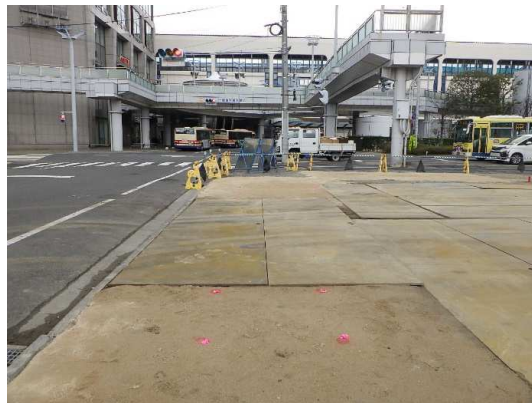
小口径回転杭工施工完了(東側を望む)
