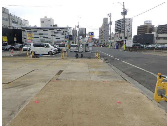
小口径回転杭工施工完了(西側を望む)
