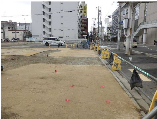
小口径回転杭工施工完了(北側を望む)
