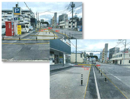
電線共同溝等施工完了状況(西側を望む)
