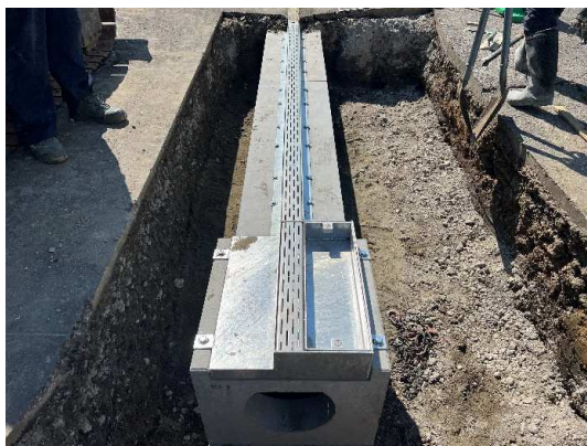
円形側溝設置状況
