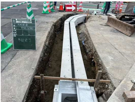
円形側溝設置状況
