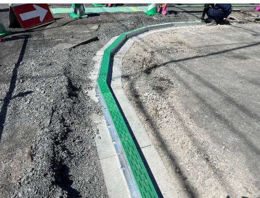
円形側溝設置状況
