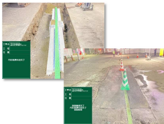
円形側溝設置状況
