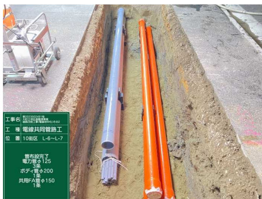
電線共同溝(管路部)施工状況
