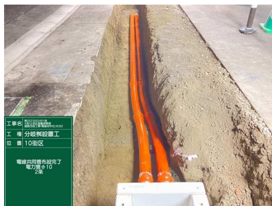
電線共同溝(管路部)施工状況
