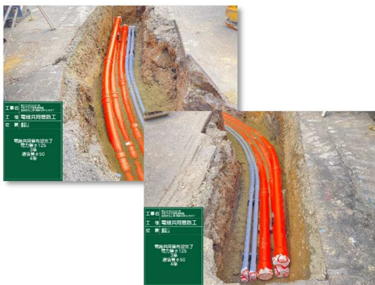
電線共同溝(管路部)施工状況
