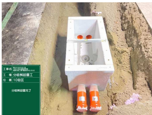
電線共同溝(管路部)施工状況
