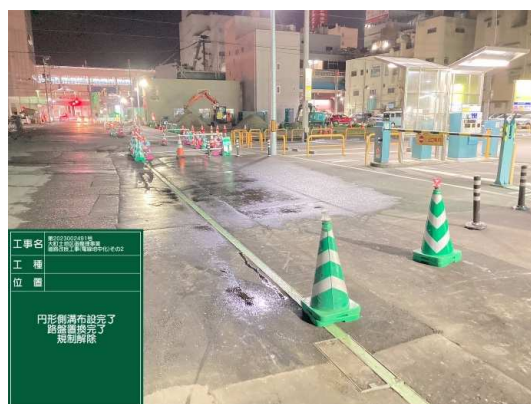
円形側溝設置完了状況
