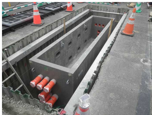
電線共同溝(特殊部)施工状況
