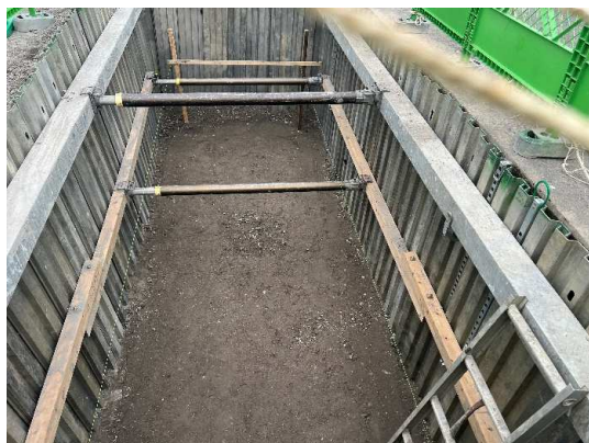
電線共同溝(掘削・土留め)施工状況
