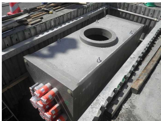
電線共同溝(特殊部)施工状況
