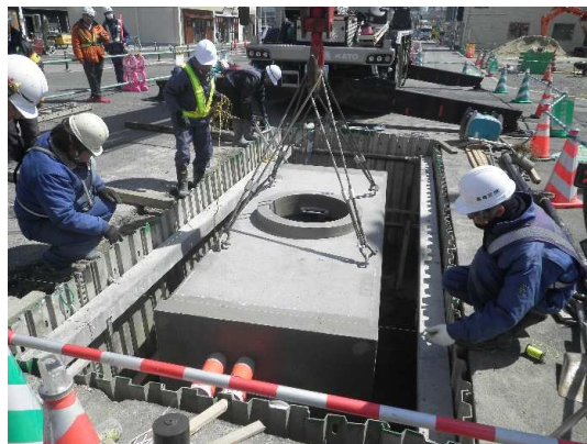
電線共同溝(特殊部)施工状況
