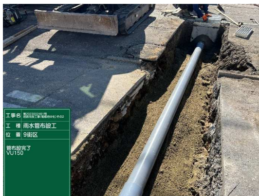
排水構造物(VUφ150)設置状況
