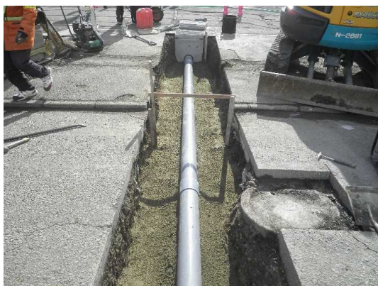
排水構造物(VUφ150)設置状況
