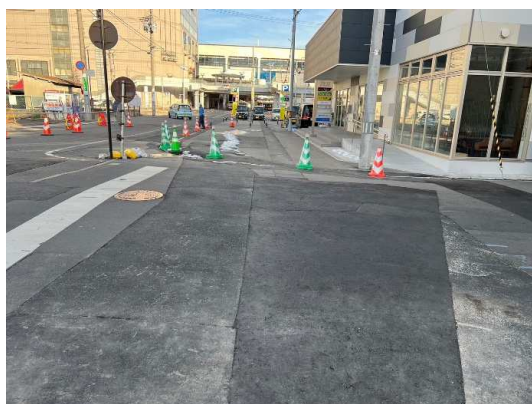
舗装仮復旧状況
