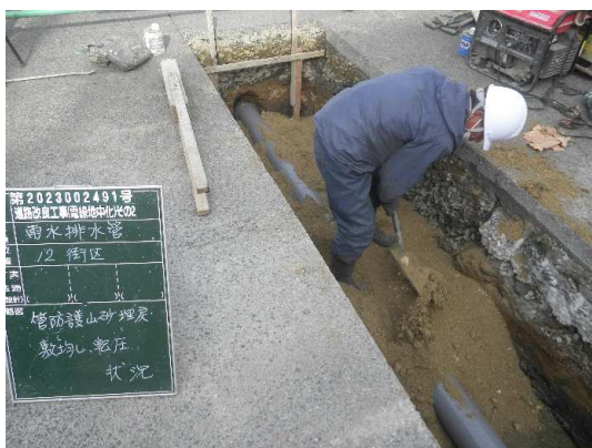
排水構造物(VUφ150)設置状況
