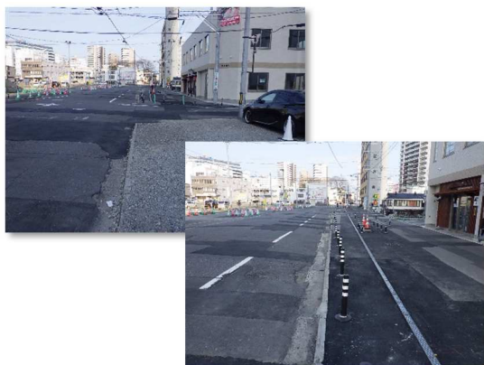
電線共同溝等施工完了状況(西側を望む)
