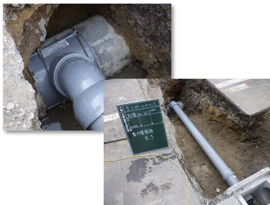
排水構造物(取付管)設置状況
