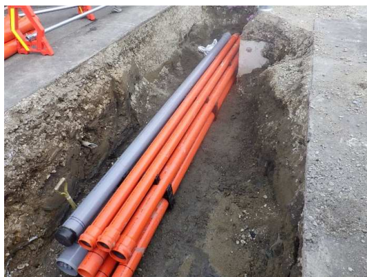
電線共同溝(管路部)施工状況
