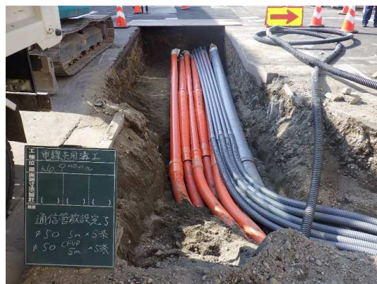
電線共同溝(管路部)施工状況
