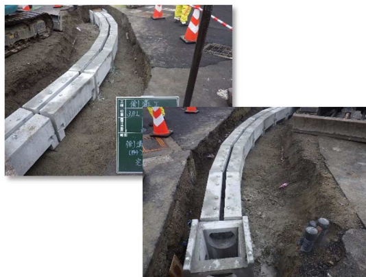
排水構造物(円形側溝)設置状況
