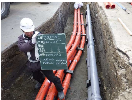
電線共同溝(管路部)施工状況
