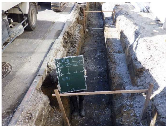
排水構造物(床掘)設置状況
