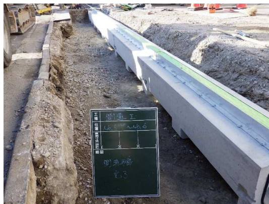
排水構造物(円形側溝)設置状況
