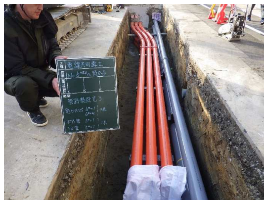
電線共同溝(管路部)施工状況
