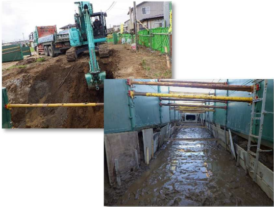
ボックスカルバート工(掘削)
