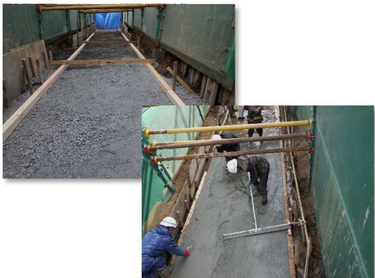
ボックスカルバート工(均しコンクリート) 施工状況
