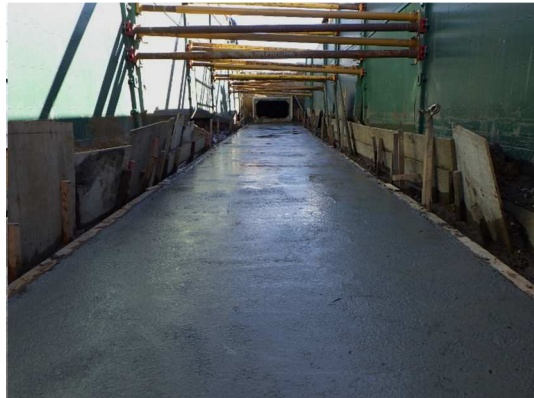
ボックスカルバート工(均しコンクリート)施工完了
