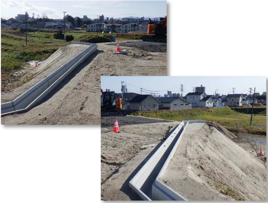
排水構造物(U型側溝)設置状況
