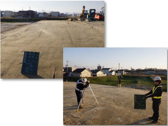
路床盛土状況
