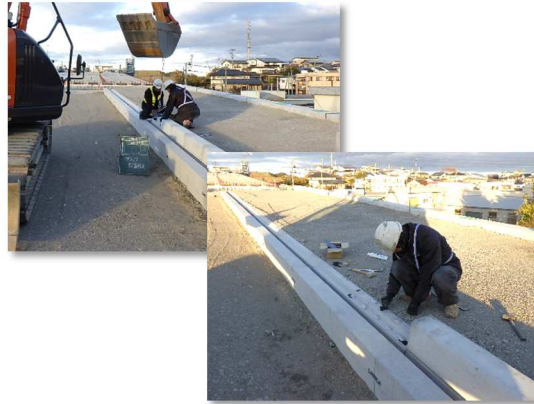
歩車道境界ブロック設置状況
