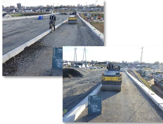
歩道路盤工施工状況
