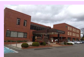
本宮市白沢公民館 本宮市白岩字堤崎500 0243-23-2350 夢図書館と隣接し、一体的に利用される公民館です。
