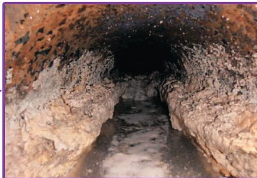
油脂分が付着した下水道管とマンホール内部
