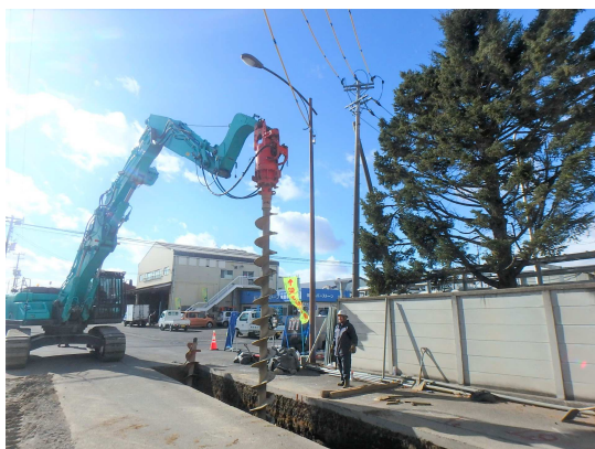
オ-ガ機による親杭設置穴掘削状況
