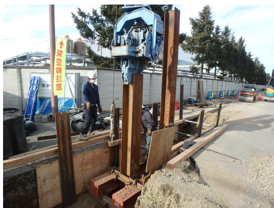
親杭設置状況（土留工）
