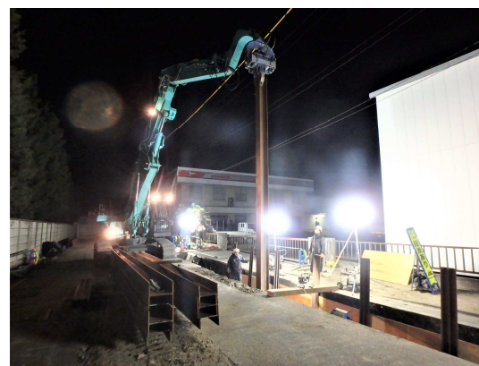
親杭設置状況（土留工）
