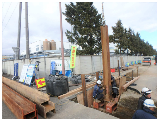
親杭設置状況（土留工）
