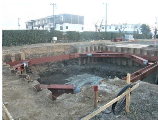
土留1段目腹起し設置完了
