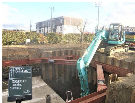
管路掘削状況
