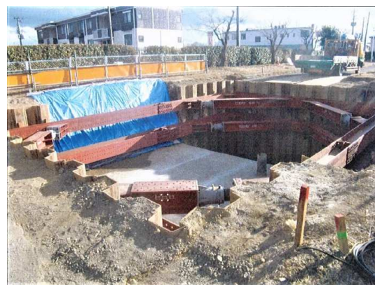
土留2段目腹起し設置完了
