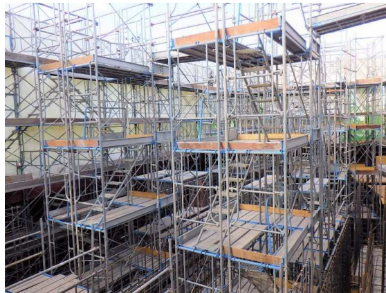
ポンプ施設部足場組立状況
