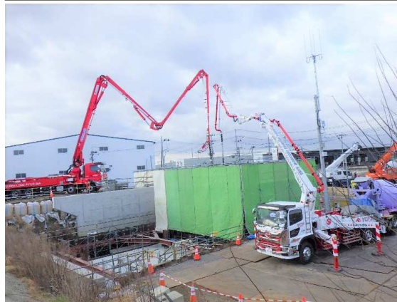
ポンプ施設部コンクリート打設状況
