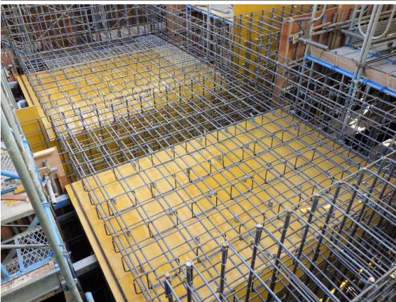
ポンプ施設部鉄筋組立状況
