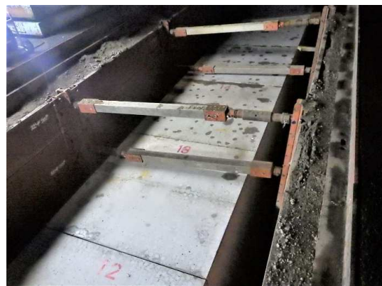
ボックスカルバート布設完了
