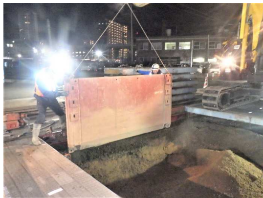
建込簡易土留設置状況
