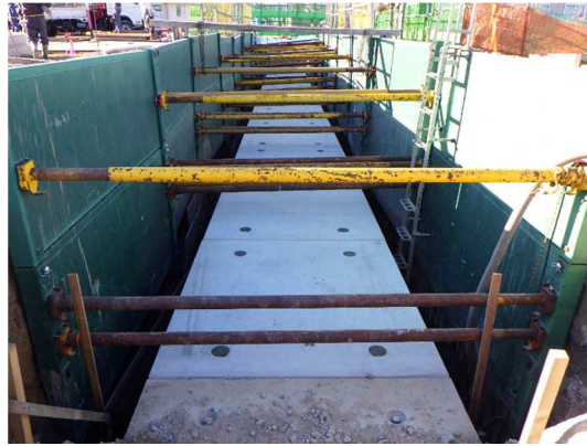
ボックスカルバート工(本体設置完了)
