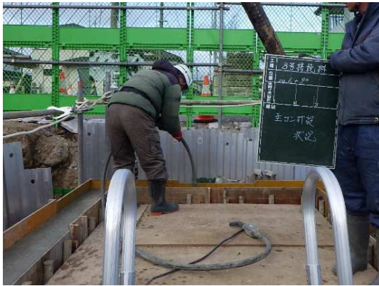
接続柵(コンクリート打設状況)
