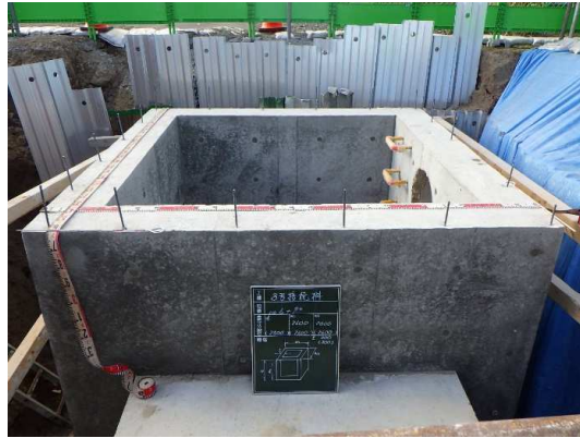
接続柵(コンクリート脱型完了)
