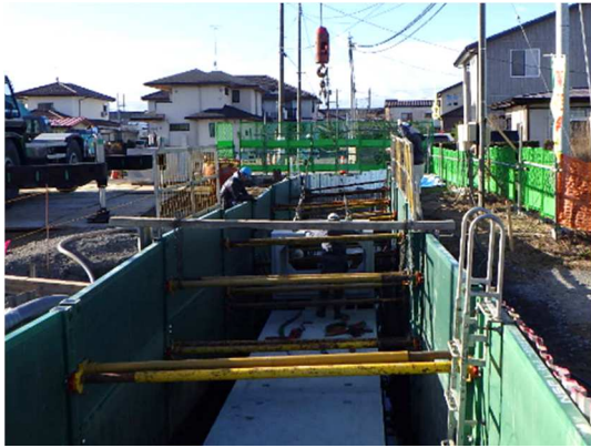
ボックスカルバート工(本体設置状況)
