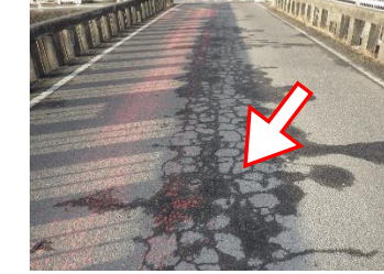
【橋面舗装の補修】
