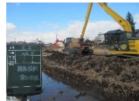
② 河道掘削工事
