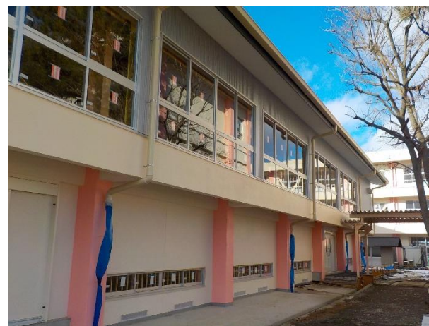
【R6 桃見台小屋内運動場 長寿命化改修】
