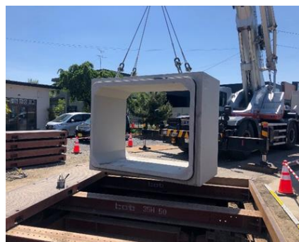
【149号雨水幹線整備】
