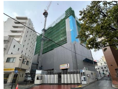
■ 現況写真(2025.1下旬)
