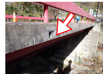
【地覆ｺﾝｸﾘｰﾄの補修】
