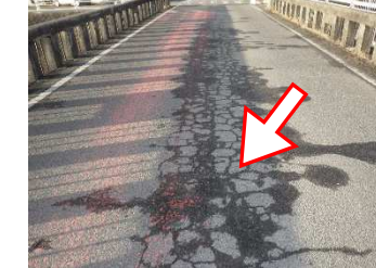
【橋面舗装の補修】
