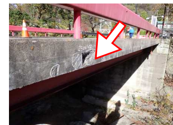
【地覆ｺﾝｸﾘｰﾄの補修】
