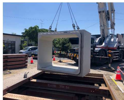
【149号雨水幹線整備】
