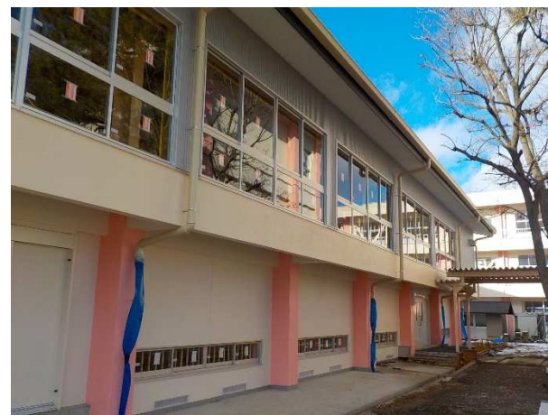
【R6 桃見台小屋内運動場 長寿命化改修】
