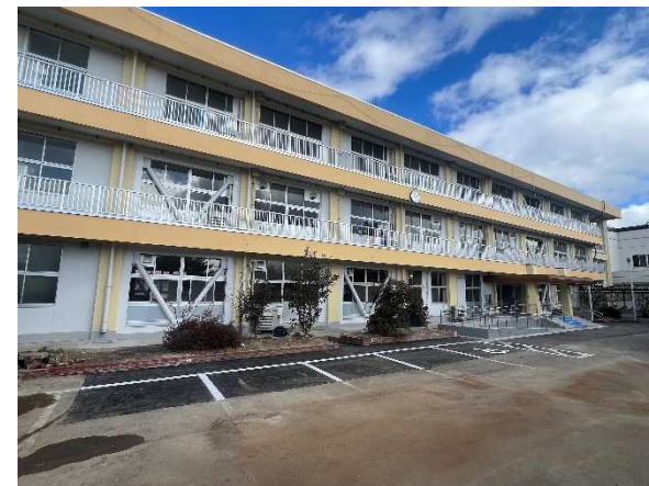
【R6 芳賀小校舎(Ⅱ期) 長寿命化改修】
