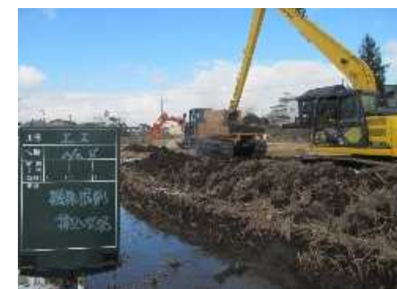
② 河道掘削工事
