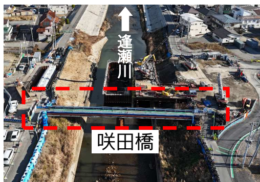
【県施工による咲田橋架替工事整備状況（2024年12月末）】
