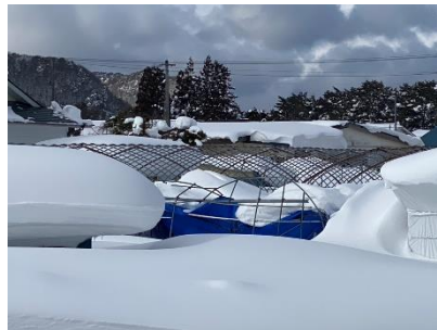
②農業用パイプハウス
