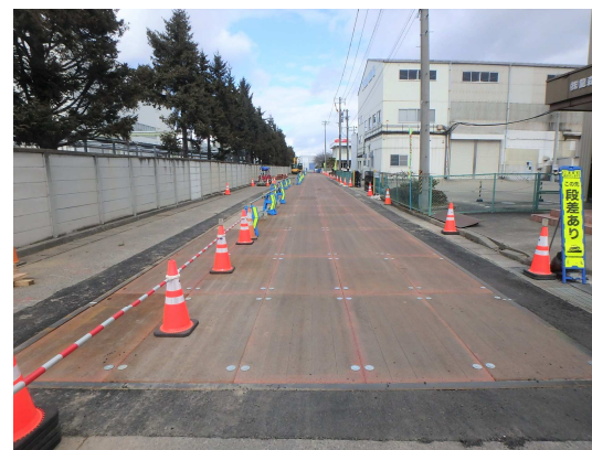
覆工板設置完了
