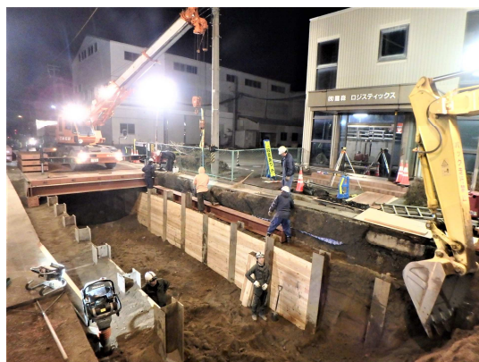
桁受設置状況（土留工）
