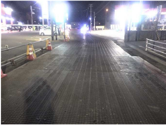
覆工板設置完了
