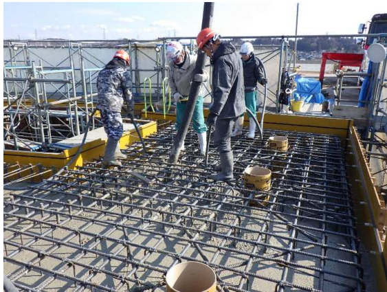
ポンプ施設部コンクリート打設状況
