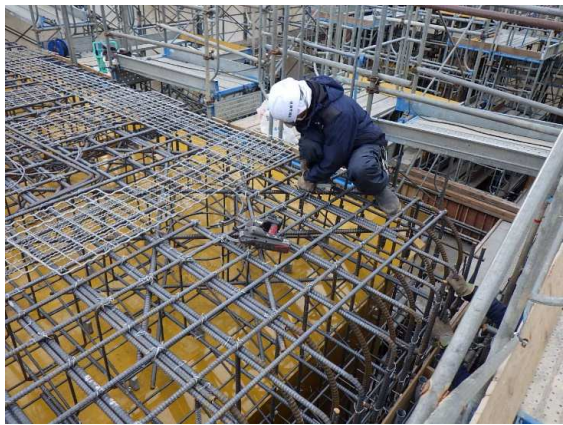
ポンプ施設部鉄筋組立状況
