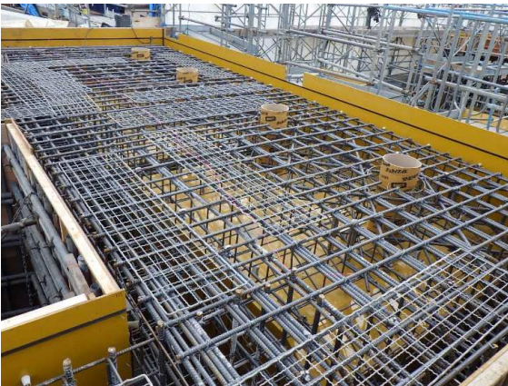
ポンプ施設部型枠施工状況
