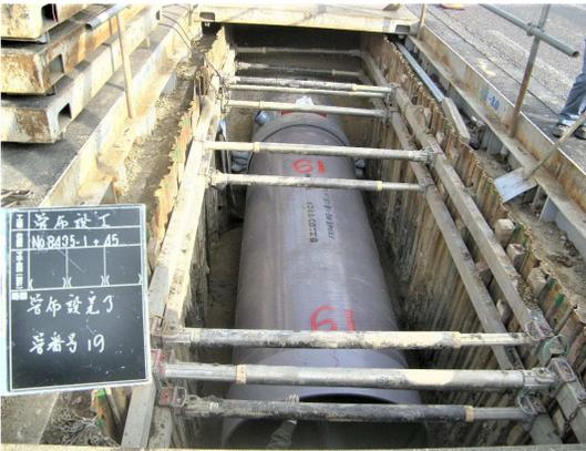
新設合流管布設完了
