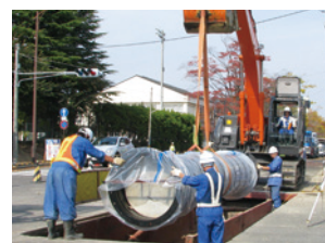
老朽化した水道施設の交換作業
